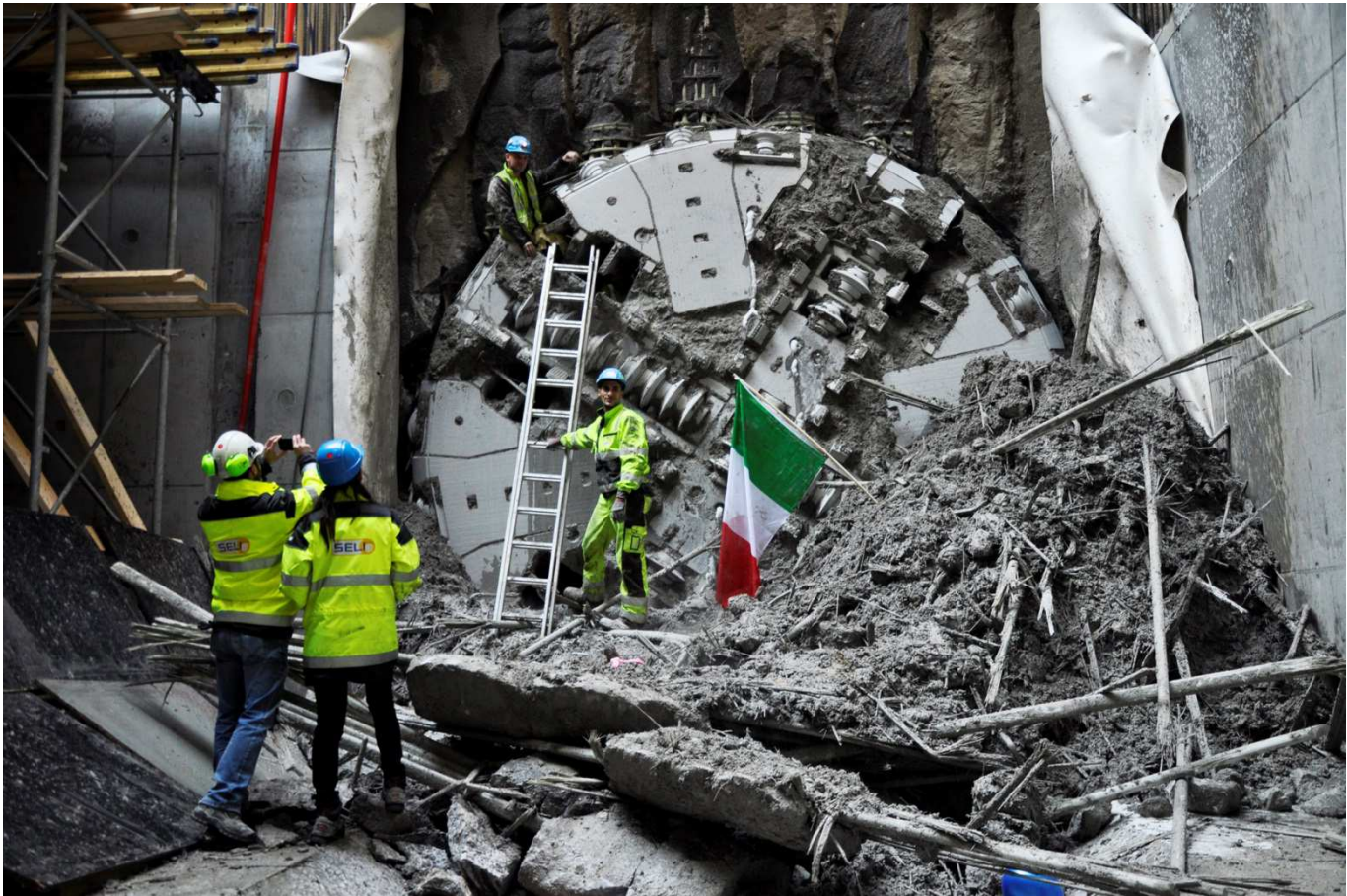
Gennembrud af tunnelboremaskinen Nora på stationen ved Nørrebros Runddel.
