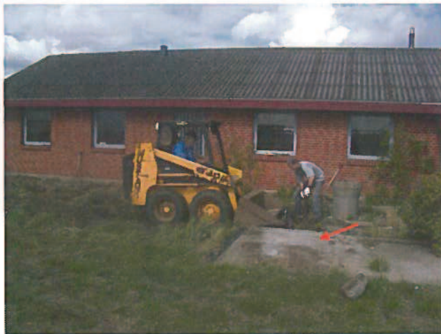
Indsendt billede af gamle fundament fra udhus.
