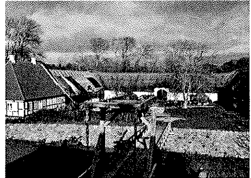
Nordre og vestre længe under restaurering
