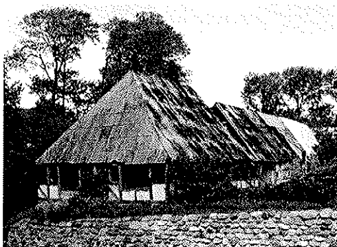
Forvalterboligen før restaurering
