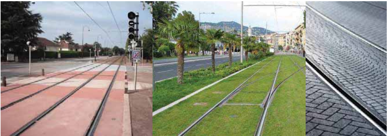
Figur 9-1: Forskellige typer overflade i sporkonstruktionen med rilleskinne.
