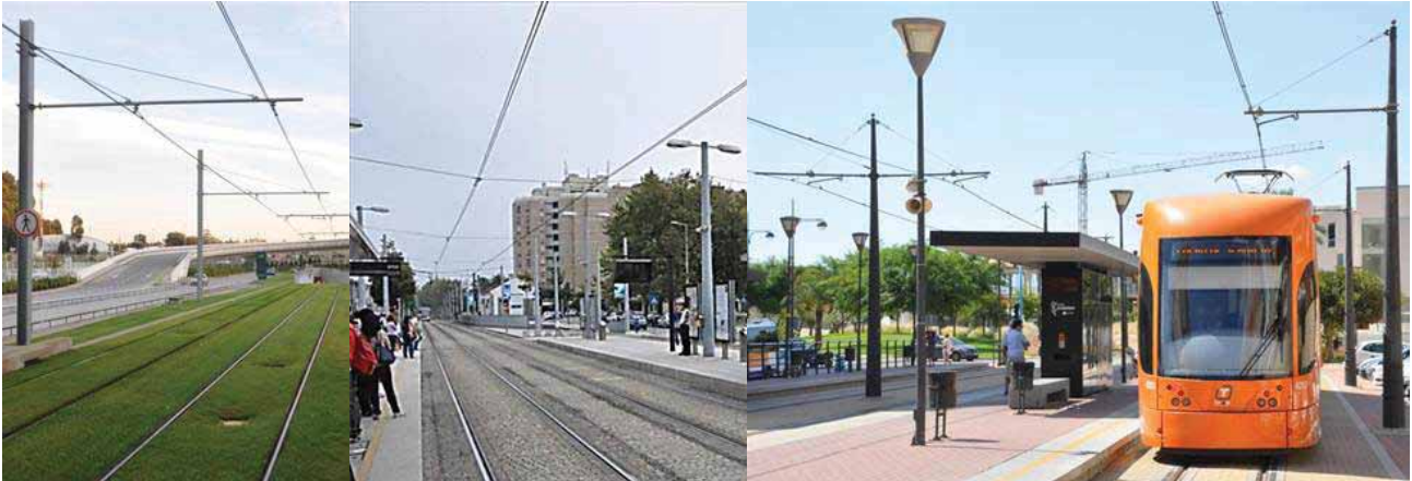
Figur 9-4: Køreledningsanlæg med 1) Sidestillet mast for to spor, 2) wirefelt mellem master og 3) midtstillet mast for to spor hhv. sidestillet mast for et spor.
