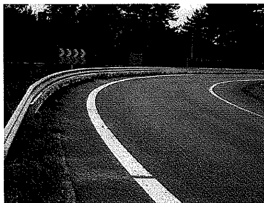
Samme motorvejsafkørsel efter de nye autoværn med motorcykelafdækning er opsat.
