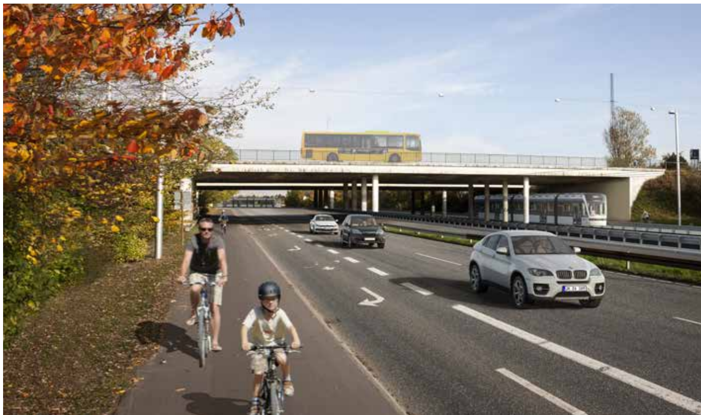
Indkørsel til letbanens kontrol- og vedligeholdelsescenter sker overfor Islevbro station i Rødovre.
