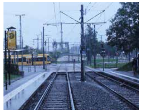
Øverst: Rilleskinnespor. Nederst: Ballasterede spor.
