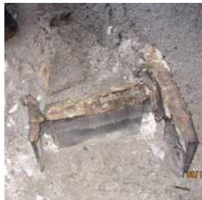
Sprængsnit af søjle. Sprængsnittet er, som det ses, næsten som lavet med en "kniv i blødt smør".
