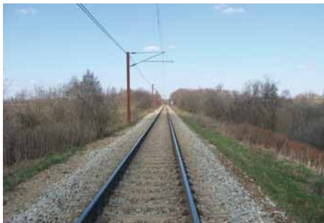
Banestrækning ved Bastrupdam.
