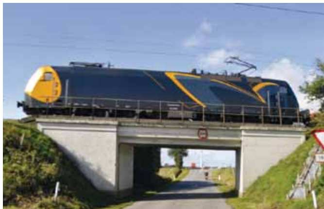
Broen over Kestrupvej er den eneste bro det er nødvendigt at ombygge som følge af projektet.
