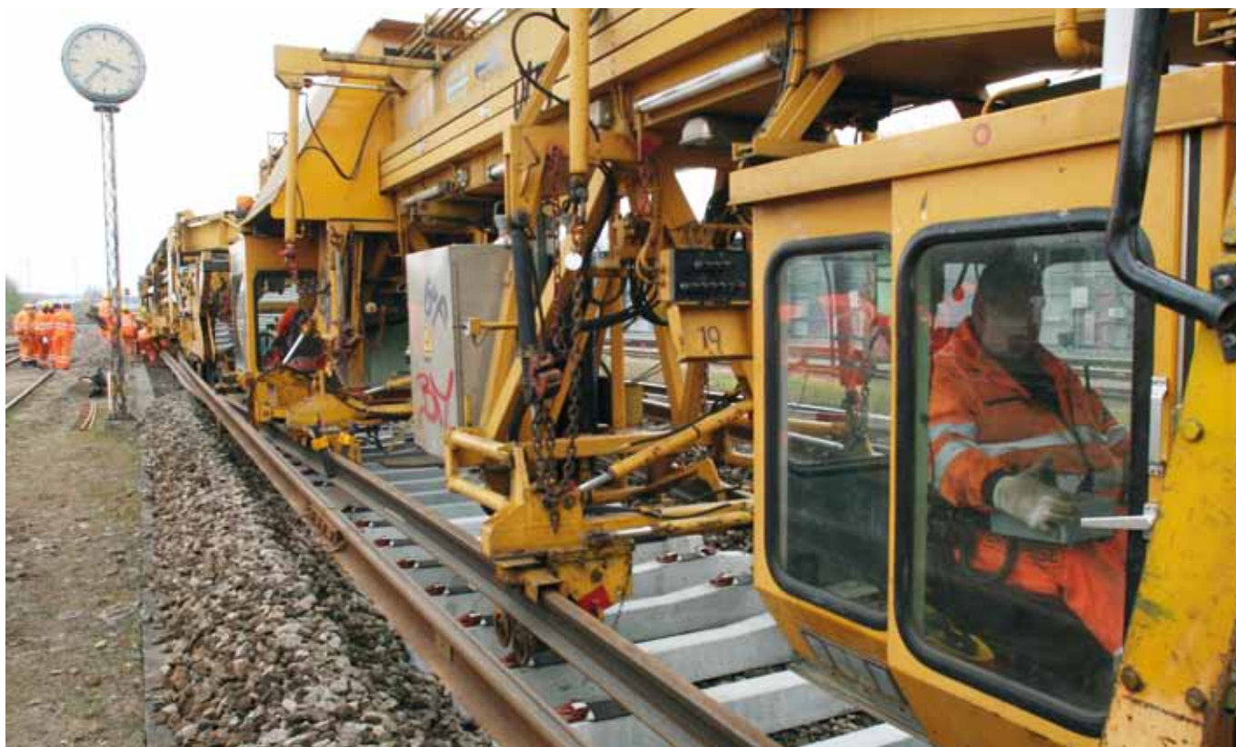
Sporombygning med anvendelse af sporombygningstog.
