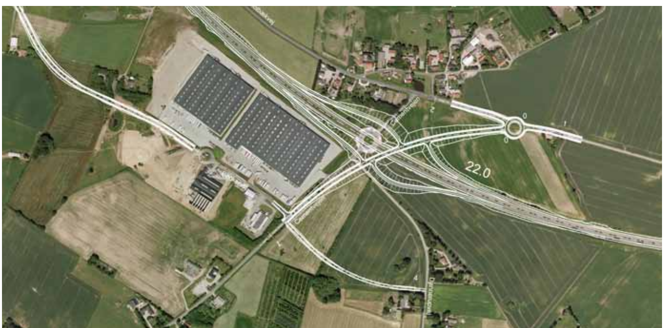
FIGUR 4.7 Tilslutningsanlægget ved Tornved
