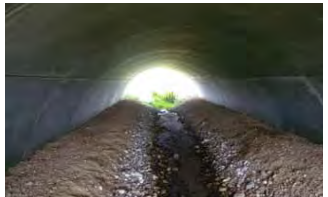
FIGUR 11.6 Vandløbsunderføring med banketter. Sikær Bæk nord for Herning.
