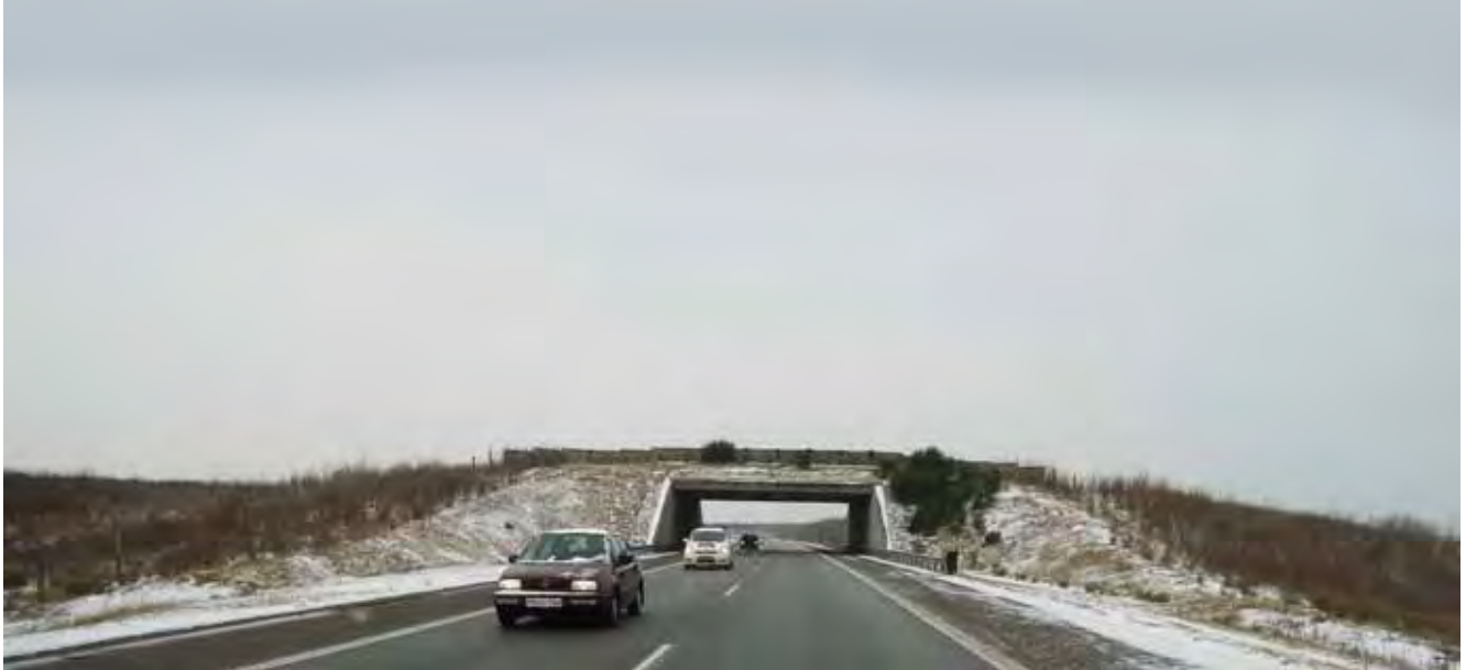
Eksisterende forhold med den 2-sporede motortrafikvej øst om Herning - med overført faunapassage som en 1-fags rammekonstruktion - set mod nordvest
