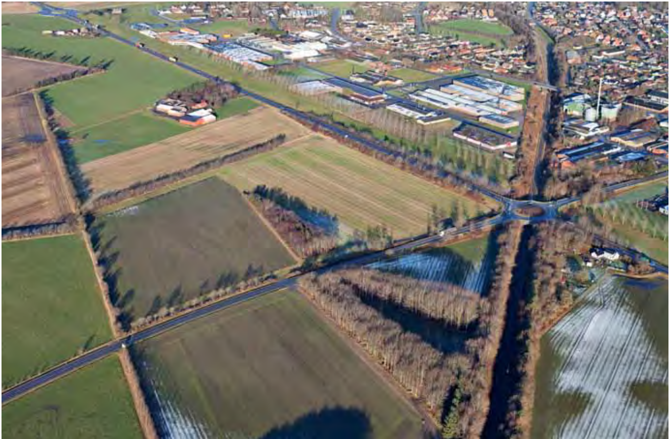
Eksisterende forhold sydvest for Aulum - hvor Videbækvej er tilsluttet krydspunktet med rute 18 og hvor jernbanen er ført under niveaufrit - set mod sydøst
