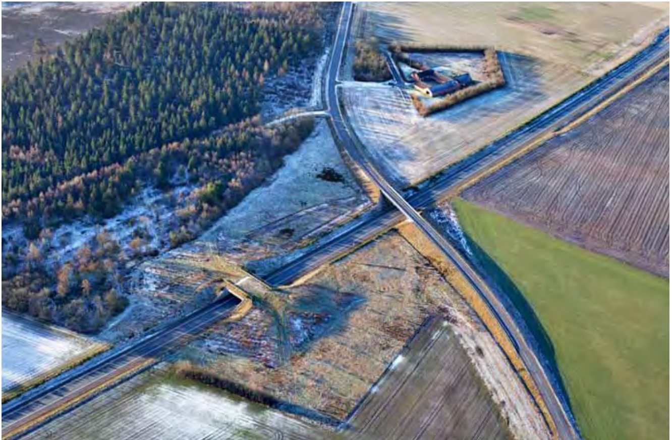
Eksisterende forhold ved Løvbakke Skov med den 2-sporede motorvej øst om Herning - her med overført faunapassage og 3-fagsbro for Sebbesandevej - set mod sydvest
