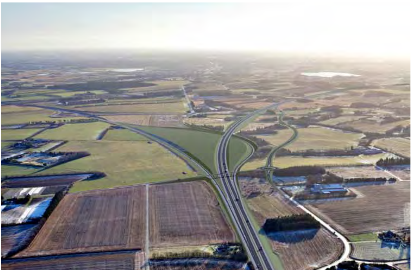
Fotovisualisering med det nye forbindelses anlæg, hvorfra den 4-sporede motorvej føres vest om Herning - den eksisterende, moderat ombyggede motortrafikvej ligger fortsat øst om Herning - Sindingvej omlægges i området vest for motorvejen - set mod syd
