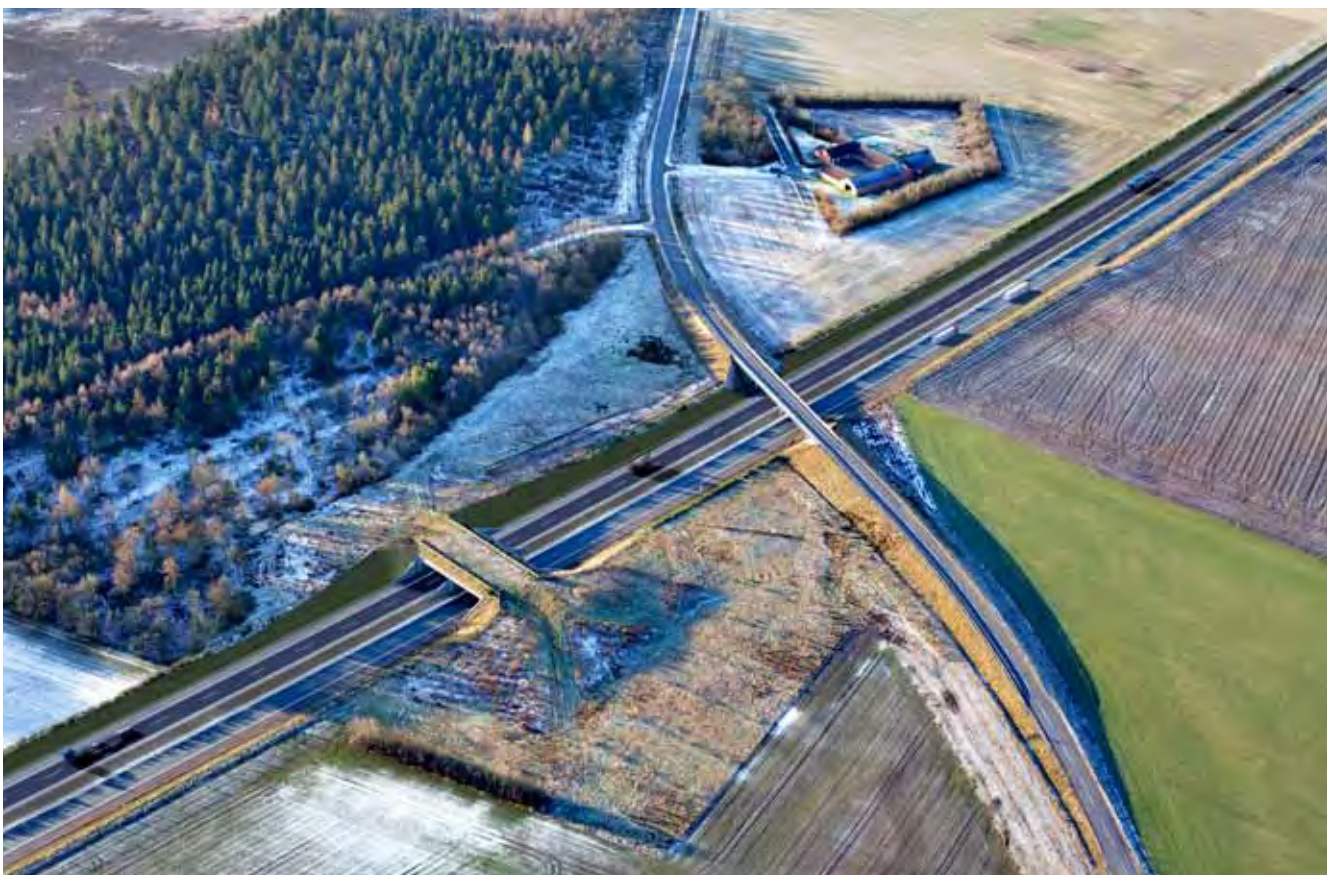
verførte faunabro udbygges til en 2-fags rammekonstruktion og broen for overføring af Sebbesandevej udbygges til en 4-fagsbro - set mod sydvest
