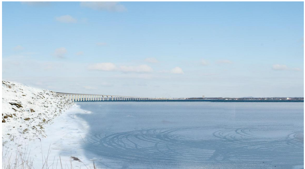
Den nye Storstrømsbro set fra Falser
