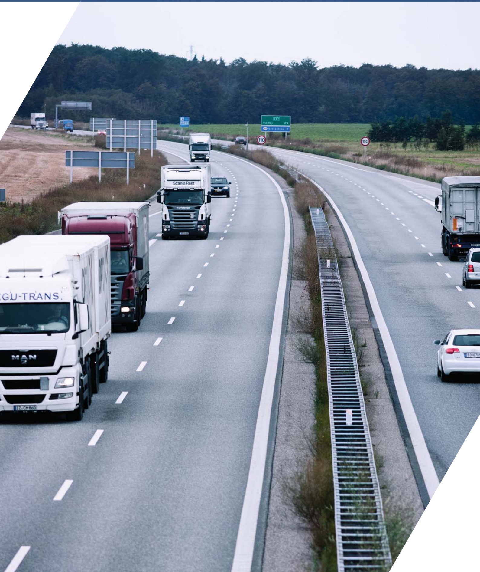
Figur 4.6: Eksisterende motorvej mellem Ønslev og Saksøbing
