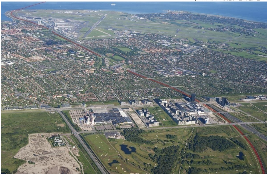
Øresundsbanens forløb set fra Kalveboderne.
