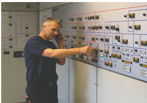
På Rødovre Pumpestation er Peter Eriksen, montør hos VEKS i færd med at regulere ventiler - sideløbende med kontakt til driftscentralen i Albertslund
