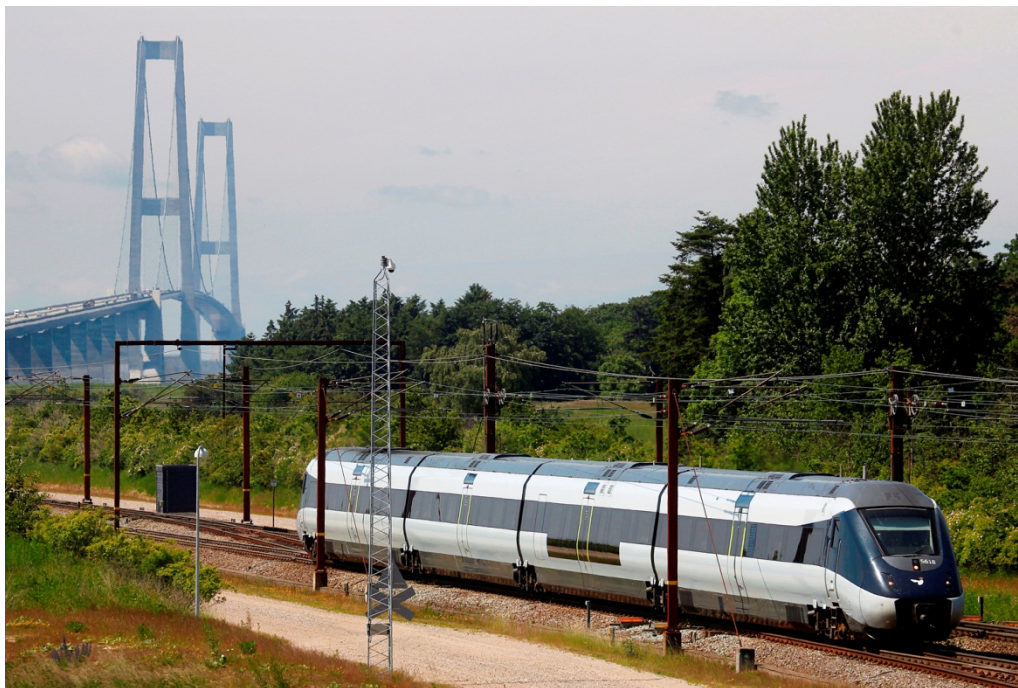
Foto: IC4-tog ved Storebæltsbroen. Kilde: DSB.
