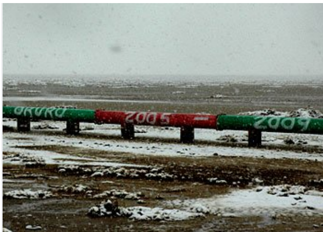
Denne store gasledning fører gassen fra Oruru til Bolivias hovedstad La Paz
