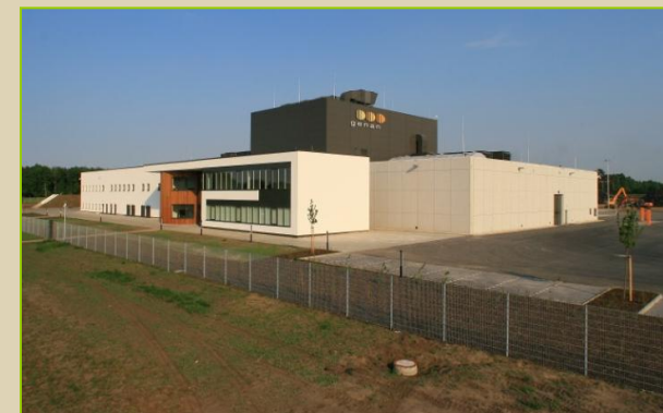
70,000 tons fabrik Dorsten, NRW, Tyskland, i drift siden 2008
