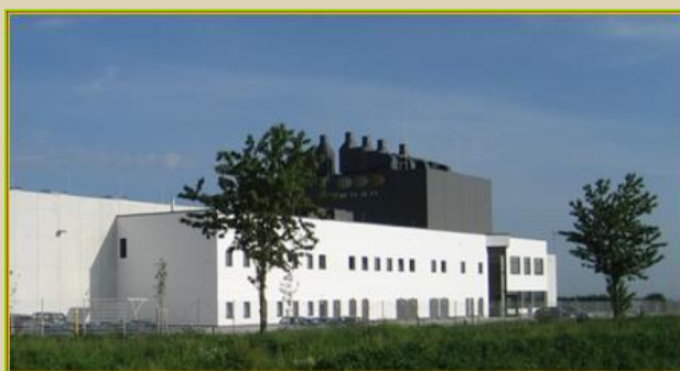
70,000 tons fabrik Mindelheim, Bayern, Tyskland, 2010
