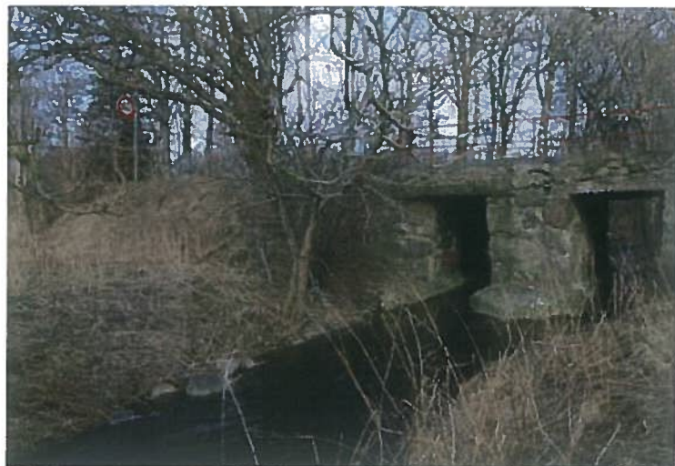
Figur 8.15 Vommevad bro er fredet. Broen berøres ikke ved en udbygning af Skovvejen
