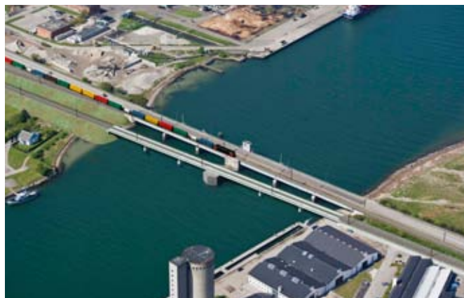
En ny bro over Masnedsund med et ekstra jernbanespor får ikke betydning for vandgennemstrømningen.
