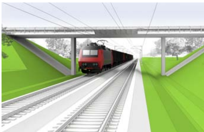
Visualisering af trefagsbro og til højre en rammebro. Broerne er designmæssigt koordinerede, således at snit, rækværk, afskærmning mod kørestrøm og kantbjælker er samstemmende.
