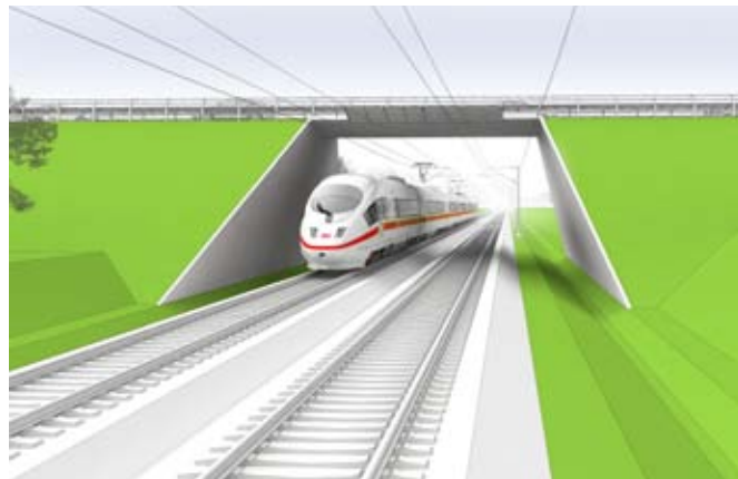
Visualisering af trefagsbro og til højre en rammebro. Broerne er designmæssigt koordinerede, således at snit, rækværk, afskærmning mod kørestrøm og kantbjælker er samstemmende.
