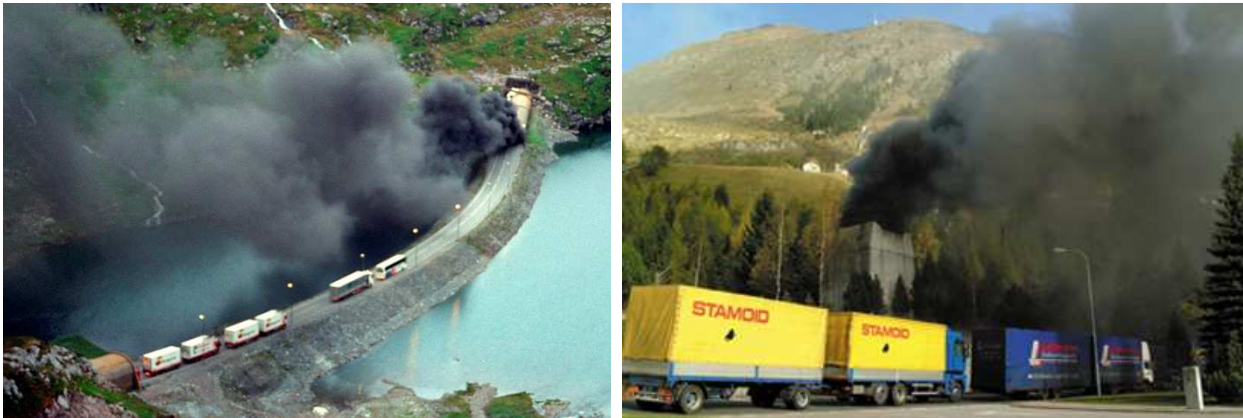
Foto nr. 1 og 2: Brand i vejttunnel med mangelfuld ventilations – og røggasudsugnings forhold.
