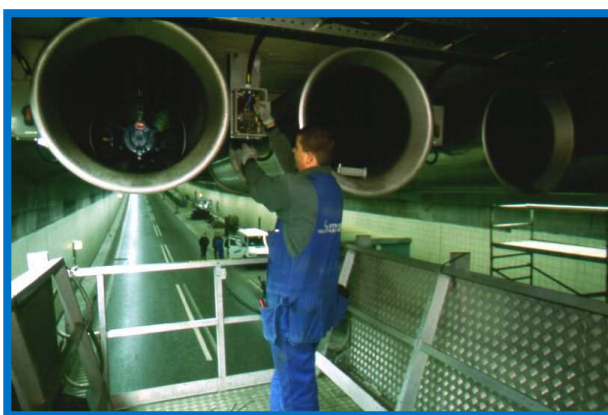
Foto nr. 7 og 8: Typiske drifts og vedligeholdelsesarbejder i vejntunnel udføres ved lukning af et tunnelrør.
