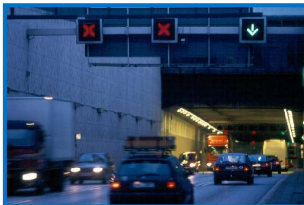
Foto nr. 5 og 6: Tunnelvask og lukning af et rør. Reversibel kørsel i andet rør i Limfjordstunnelen.
