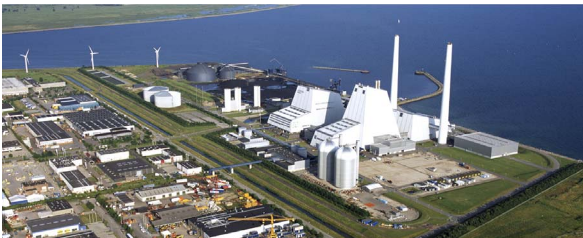
Flyveaskesilo Skivemøller (ikke synlige) Affaldslager
