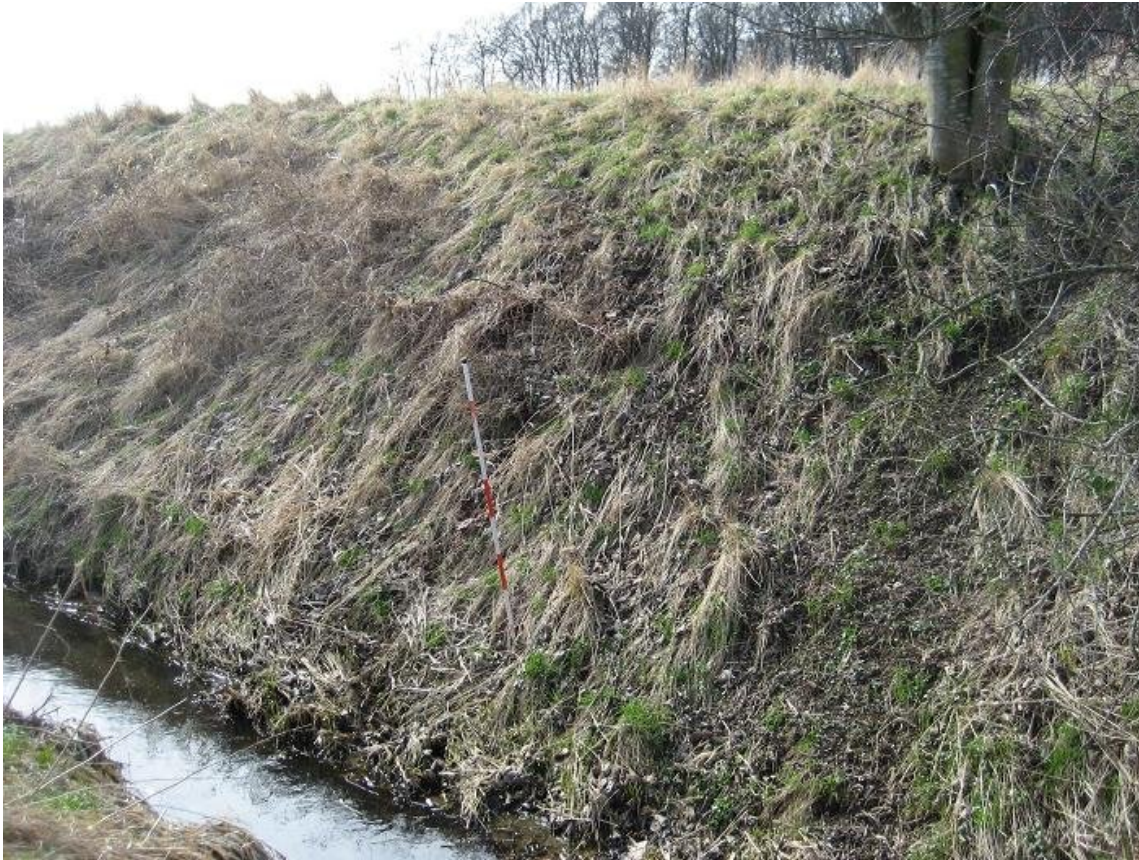
Figur 6. Stor Å. Foto Jan Hjed. omfattende jordarbejde, hvor vandløbet er nedgravet i over 4 meters dybde, vidner om meget betydelige afvandingsinteresser, som varetages af vandløbet.
