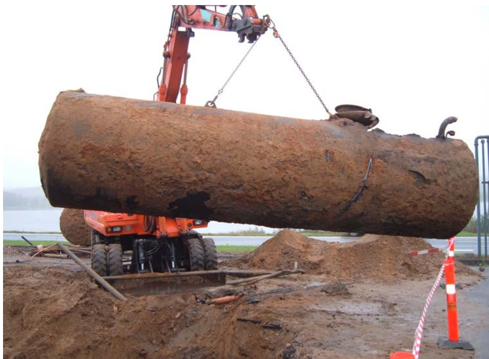
Tankopgravning i forbindelse med en OM-oprydning. Foto: Region midtjylland
