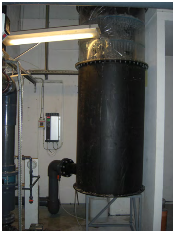
Figur 3.8 Foto af rislereaktor med (ozon- og THM-stripper) afløb til udligningstank.
