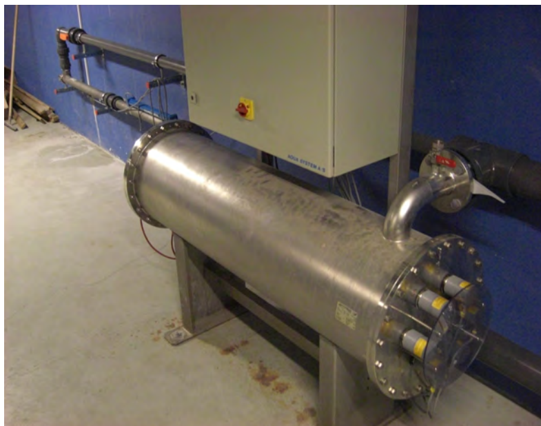
Figur 3.2 Foto af den afprøvede Chlorinator CLIII 30 placeret i sidestrøm.
