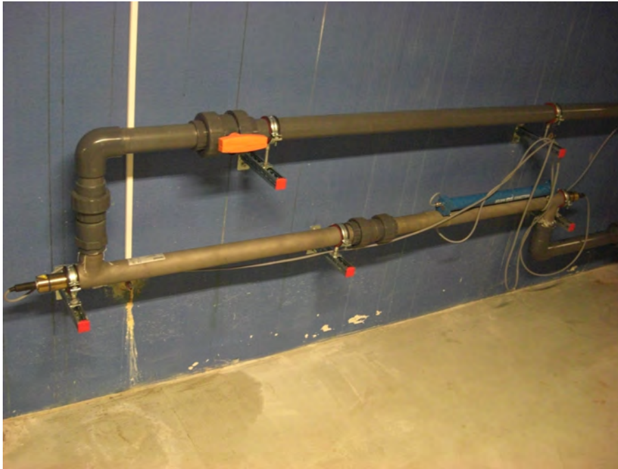
Figur 3.5 Foto af den afprøvede Wallenius AOT M900P placeret i delstrøm i Gladsaxe Svømmehal.
