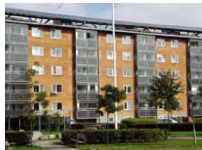
Solgården i Kolding har solceller på taget
