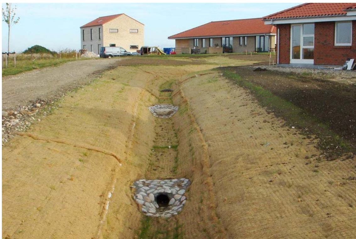
Grøft til regnvandsafledning ved Trekrøner. Foto: Ole Fryd.
