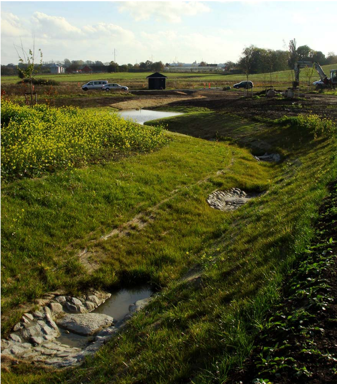
Anlæg til opsamling af regnvand i Trekrøner. Foto: Ole Fryd
