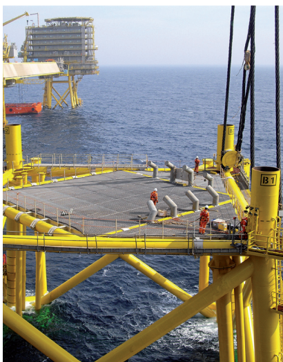
Installation af understel til Halfdan BD platform 2010.
