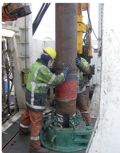
Foringsrør installeres i boring ved Sønderborg.
