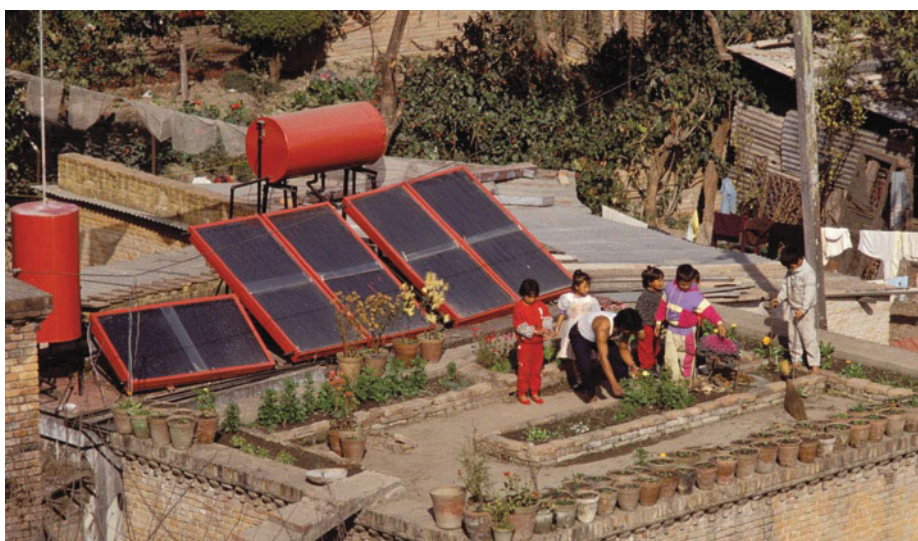
I Nepal har Danmark støttet, at 43.000 husholdninger har fået elektricitet fra solpaneler. Foto: Jørgen Schytte / Danida.
