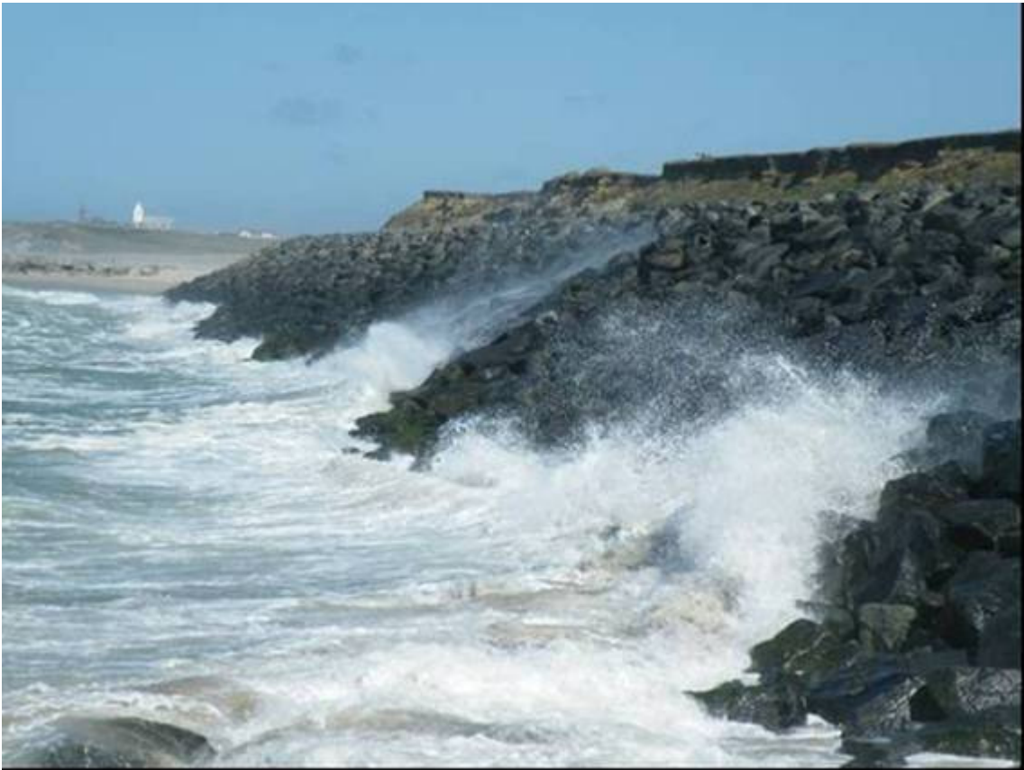
I 2009 byggede KDI ny skråningsbeskyttelse for 9 mio. kr
