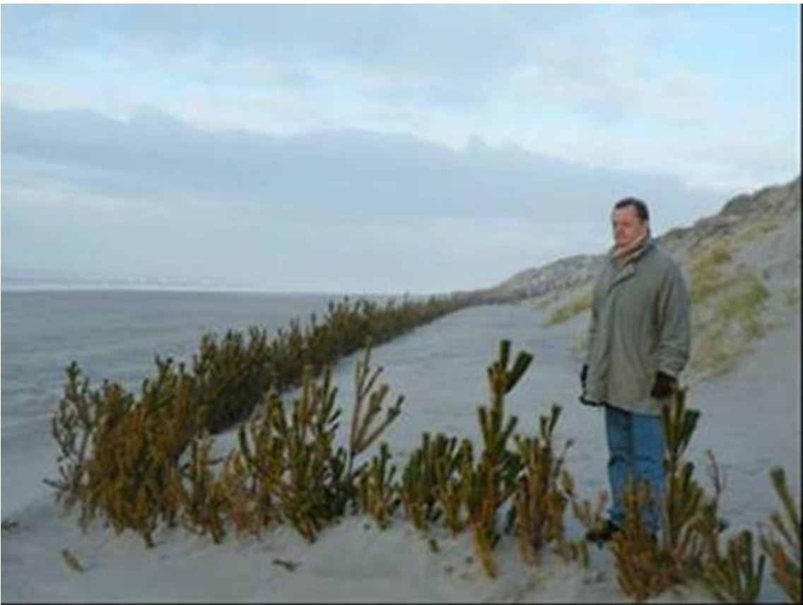
Efter 6 uger var der aflejret ca. 10 – 15 kubikmeter pr. meter bag faskinerne
