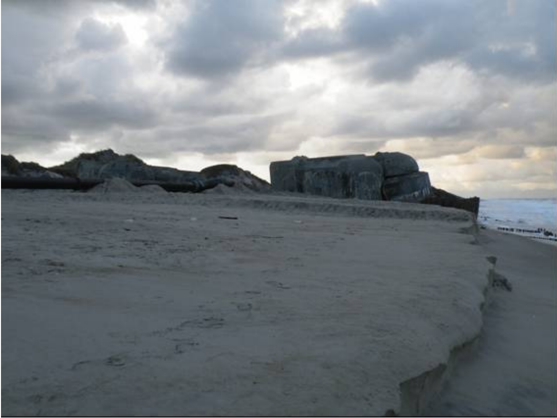
Vi ser her at erosionen er startet før rørene er fjernet fra stranden
