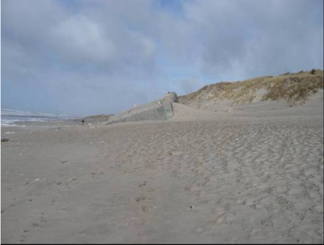
Bunkeren i SIC projektet ved Skodbjerge er nu næsten tildækket med sand
