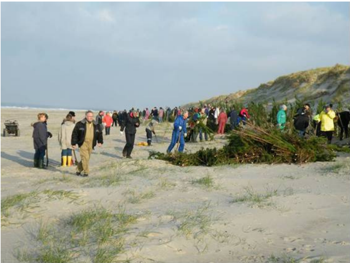
Vi ser her 250 grundejere i gang med at sætte faskiner i forstranden d. 8. november 2008 Faskinerne blev sat på en 500 meter lang strækning ved Bjerregård
