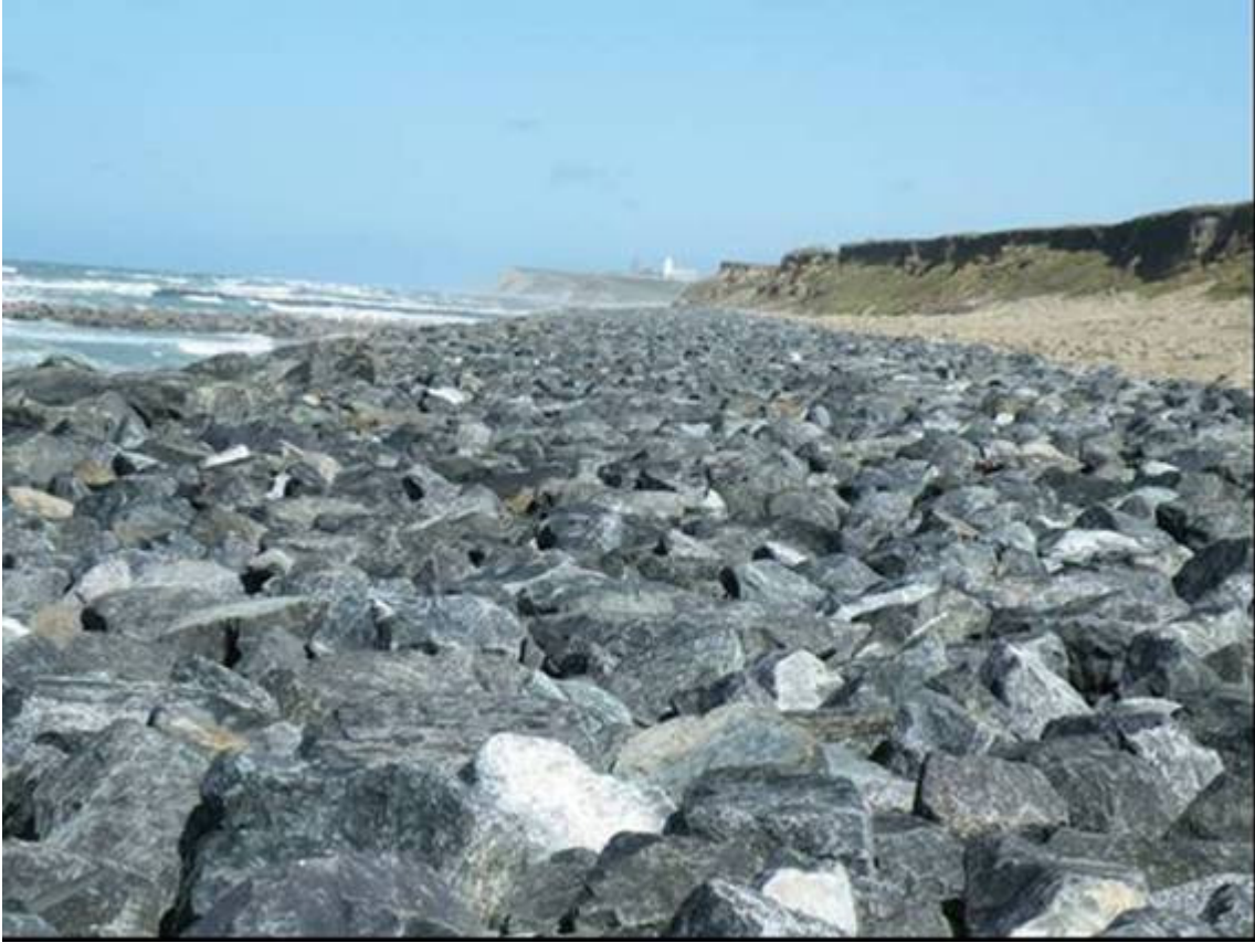
I dette projekt blev stranden fyldt op med norske brudsten i 20 meters bredde.
