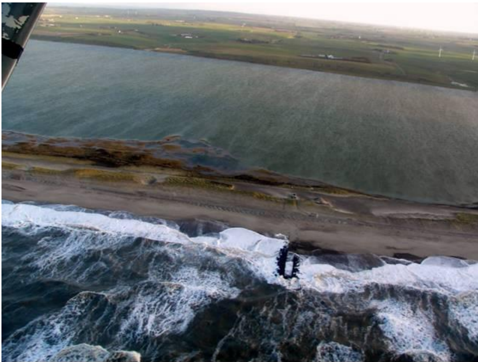
Sandfodring og høfder har heller ikke kunnet stoppe erosionen ved Ferring
