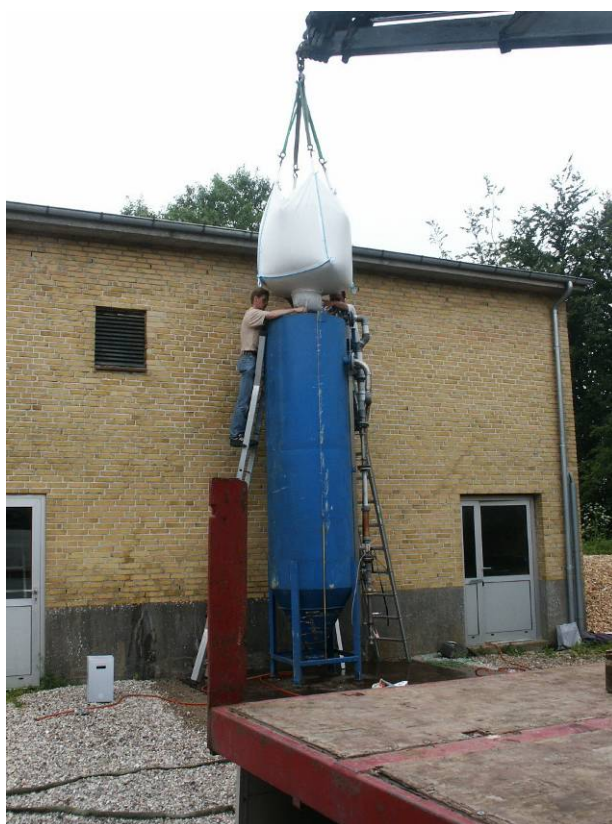
Figur 4-7 Påfyldning af sand i pilotanlægget ved Nørre Aaby.
