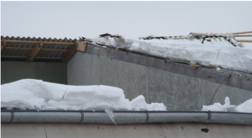
Bygning 1 set fra nordvest. 6 februar 2010.
