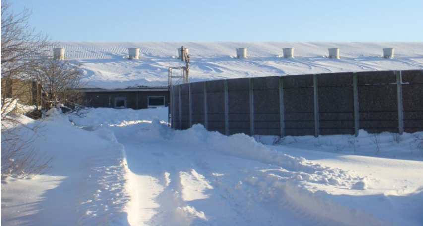
Bygning 1 set fra vest. 7 januar 2010.
