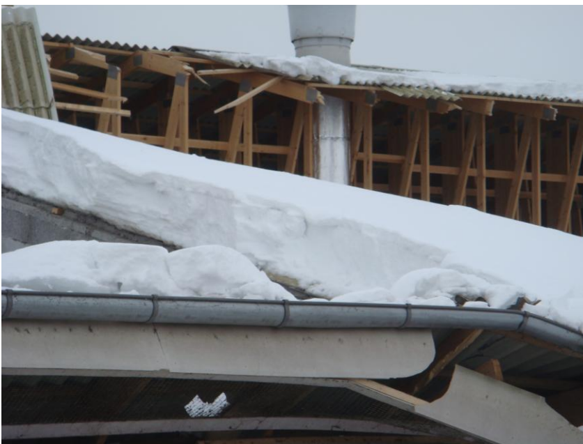
Bygning 1 set fra nordvest. 6 februar 2010.
