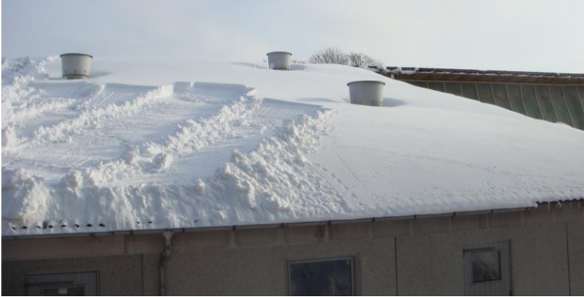
Bygning 1 set fra vest. 6 februar 2010.
