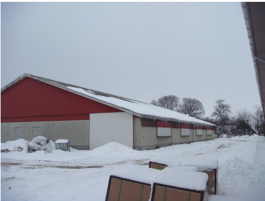
Bygning 2 set fra syd. 7 februar 2010.
