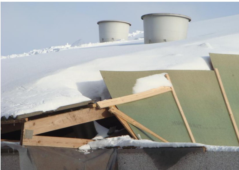
Bygning 1 set fra vest. 6 februar 2010.
