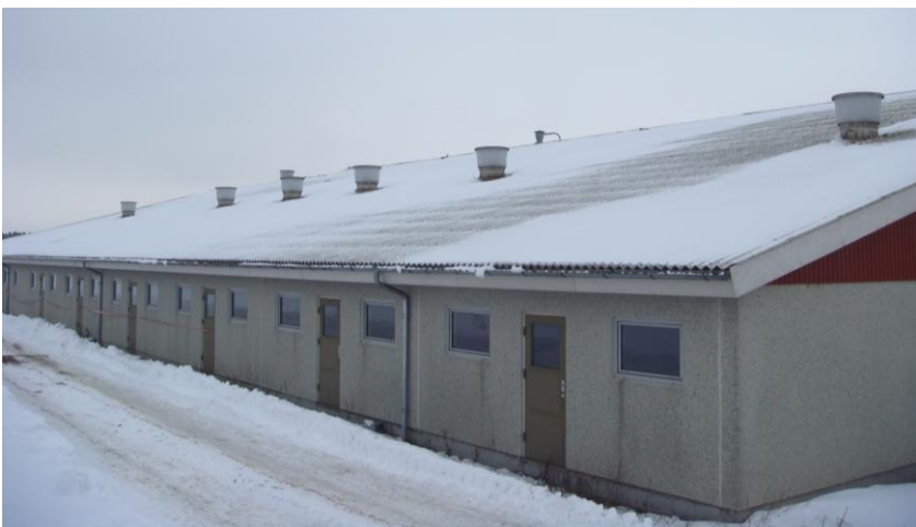
Bygning 1 set fra nordøst. 6 februar 2010.
