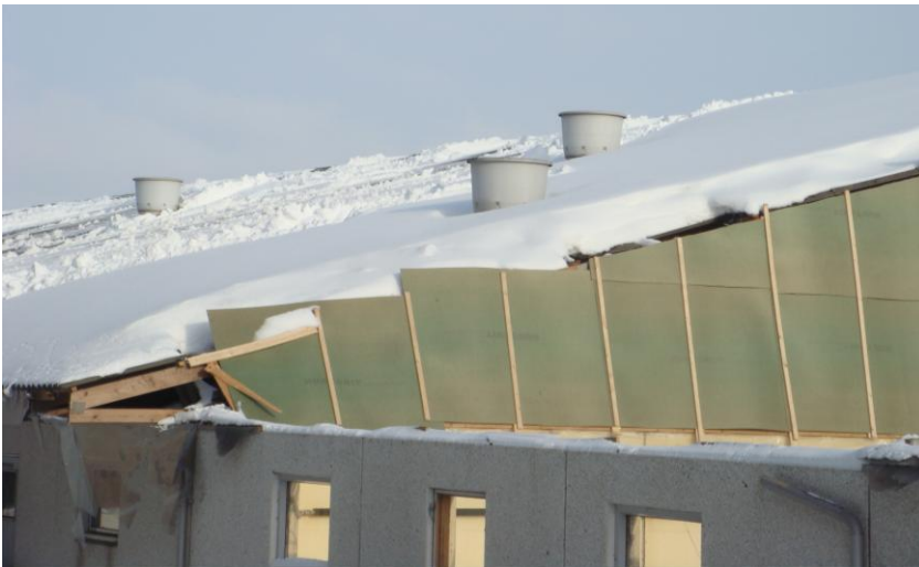
Bygning 1 set fra vest. 6 februar 2010.
