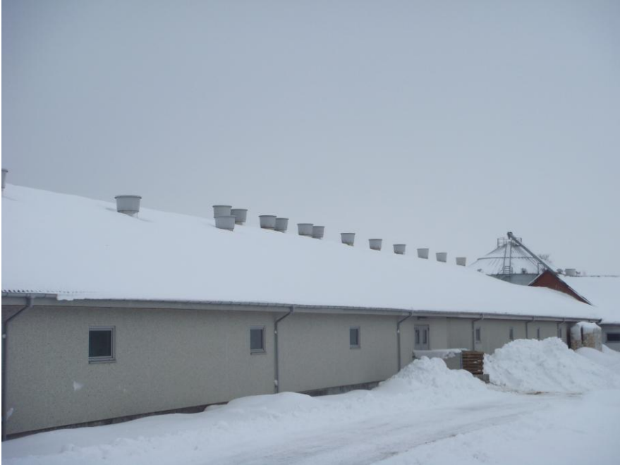
Bygning 1 set fra syd. 7 februar 2010.
