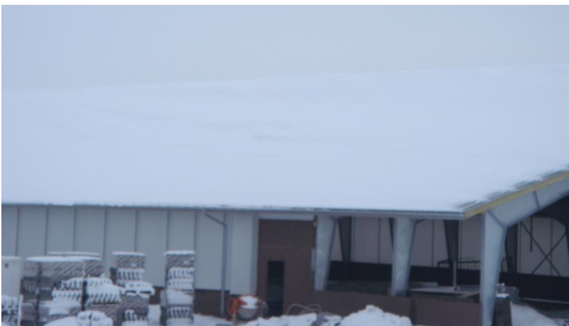
Østligste bygning set fra sydvest. 6 februar 2010.
