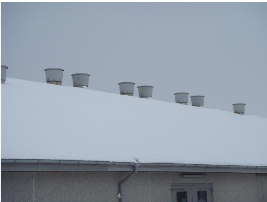
Bygning 1 set fra syd. 7 februar 2010.
