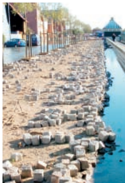
Dagen derpå efter højvande i Nakskov havn i november 2006, hvor vandstanden var 180 cm over daglig vande, og hvor huse, biler og belægning blev beskadiget.
