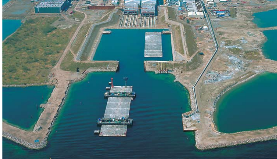
Elementerne til en sænketunnel støbes på land, samles i sektioner og sejles til tunnel-renden, hvor de placeres et efter et. Foto af produktionsanlæg til Øresundstunnelen.
