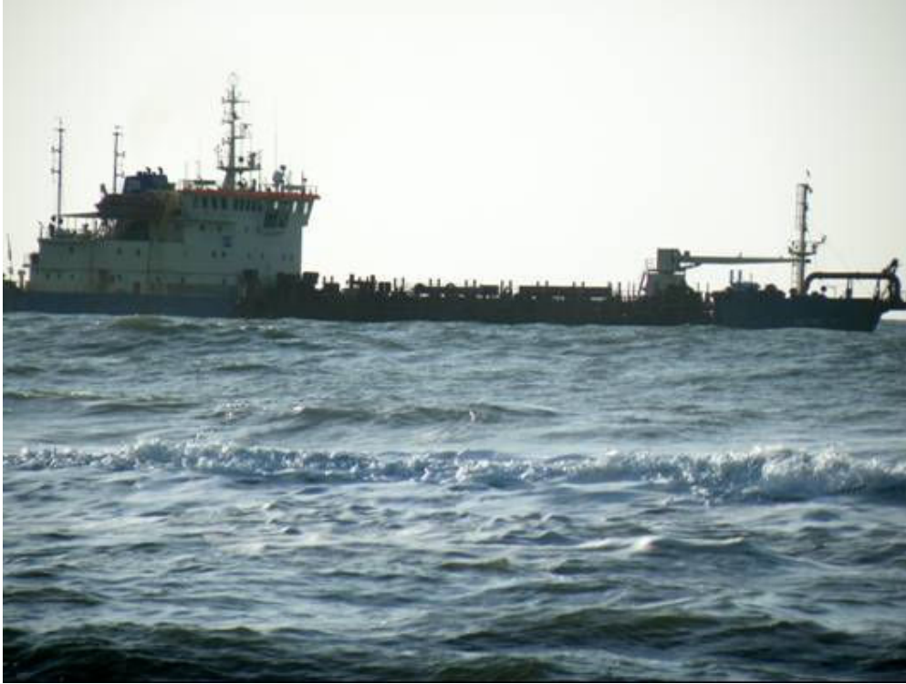
Sandindpumpning til nye klitter ved Houvig Oktober 2008
