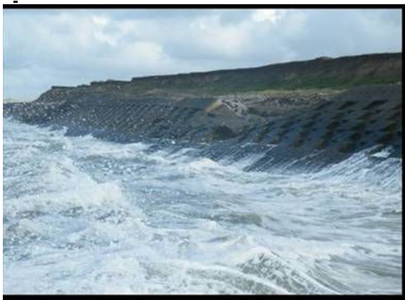
Høfderne ved høfde Q er totalt virkningsløse og skråningsbeskyttelsen er nu ved at kollapse.
