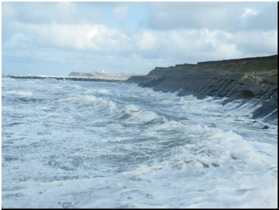
Høfderne ved høfde Q er totalt virkningsløse og skråningsbeskyttelsen er nu ved at kollapse.
