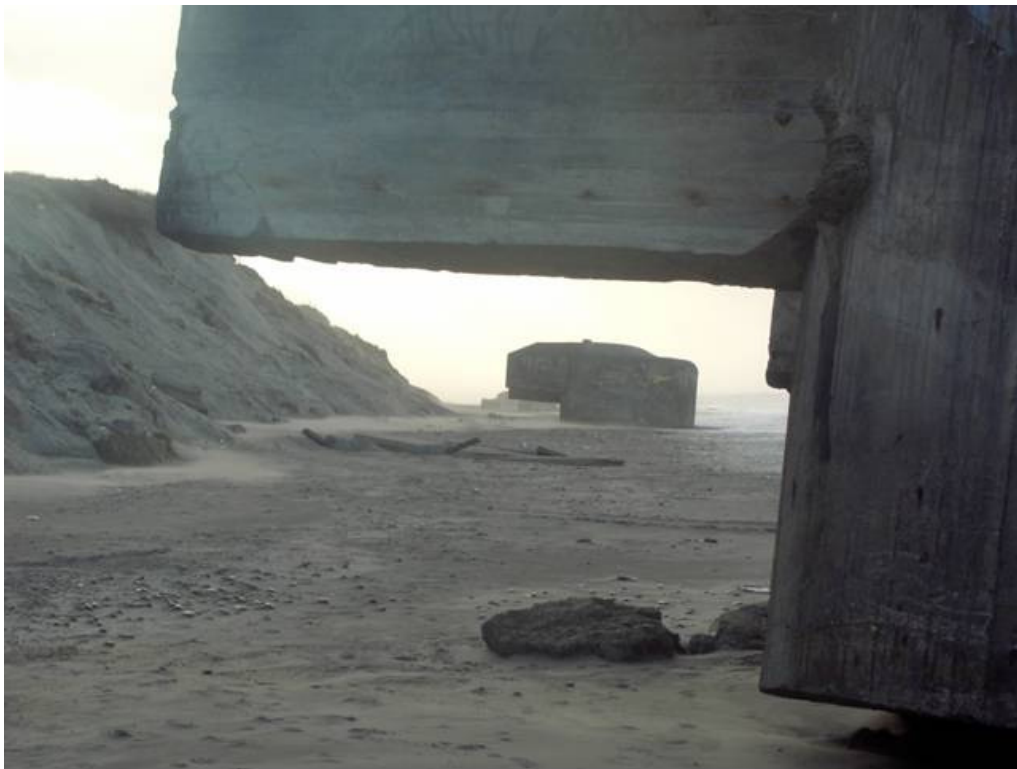
Søndervig i januar 2005 efter sandfodring med 86.900 m 3 sand i 2004 Bunkerne stod 25 meter ude på stranden
