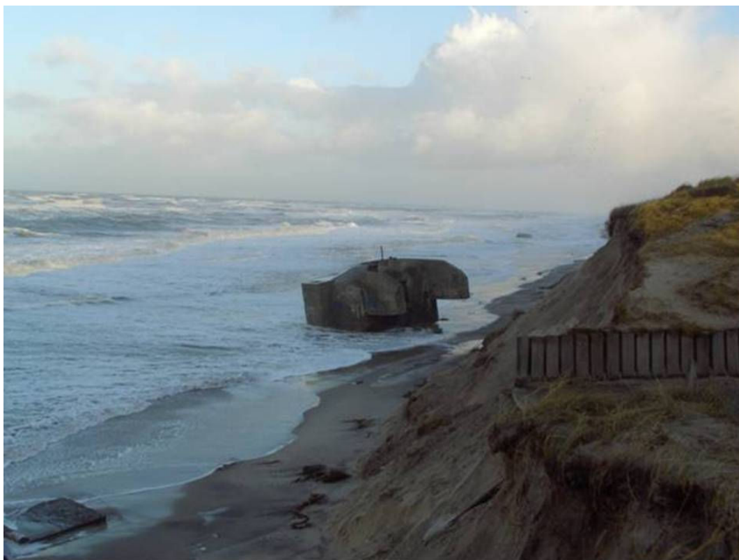
Bunkeren ved Søndervig stod 25 meter ude på stranden efter januar stormen i 2005. Sandfodring i efteråret 2004 var reelt virkningsløs
