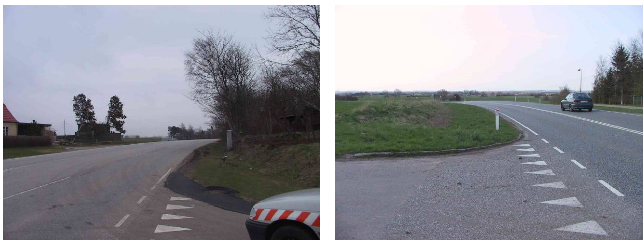
Figur 6. Eksempler på dårlig sigt i kryds pga. primærvejs forløb (kurve) fra rute 21.
