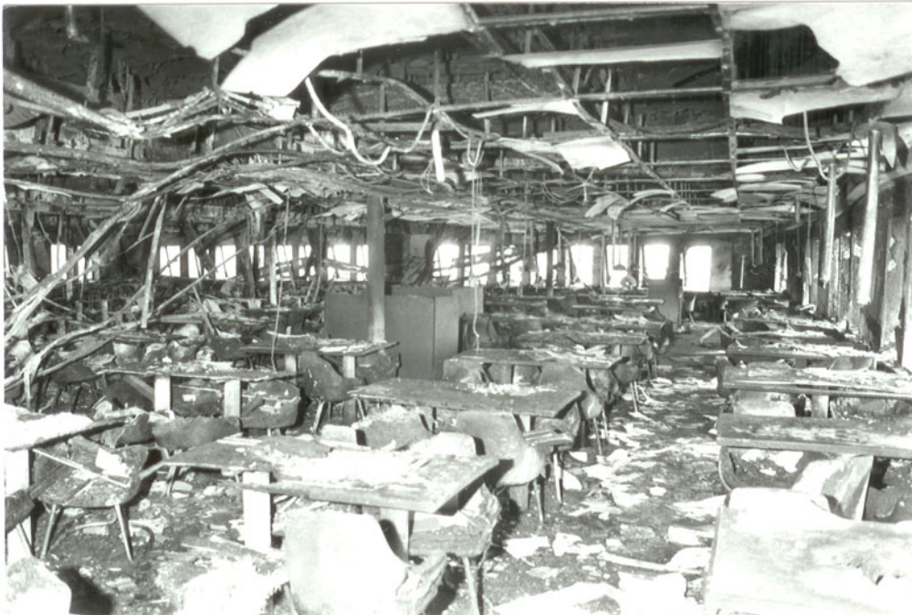
Figur 13. Bild visande restaurang i främre delen av däck 6. De kraftiga brandskadorna är sannolikt ett resultat av brand nr. 6.
