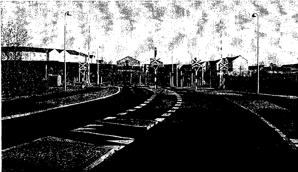
Eksempel på kombineret overkørsels- og gadesignalanlæg.
