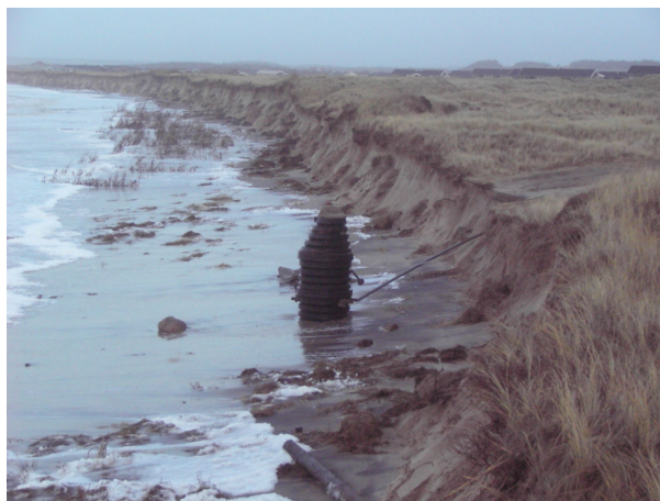
Høfderne ved Skallerup Klit har medført stor læsideerosion nord for høfderne.
