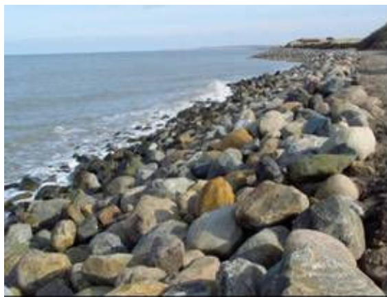
Bølgebryderne ved Lønstrup har medført stor læsideerosion nord for Lønstrup.
