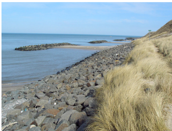
KDI sandfodrer bølgebryderne ved Lønstrup hvert år for at bevare konstruktionerne
