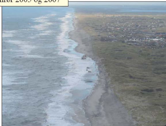
Søndervig d. 16 januar 2007 efter en investering på 42,0 mio. kr. i strand- og reviefodring. Strandfodringen er skyllet i havet, og havet har taget ca. 400.000 m 3 af klitterne. Vandstand: +50 cm. (Foto: P. Jakobsen)
