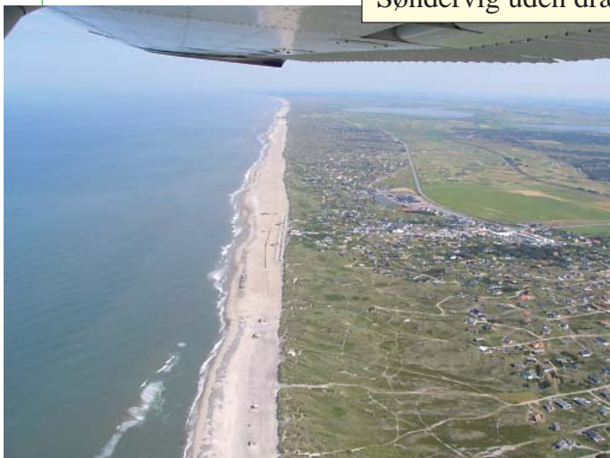
Sandfodring ved Søndervig d. 5. juli 2005 efter strandfodring med 960.000 m 3 sand på stranden. Vandstand: +45 cm. (Foto: P. Jakobsen d. 05-07-2005)
