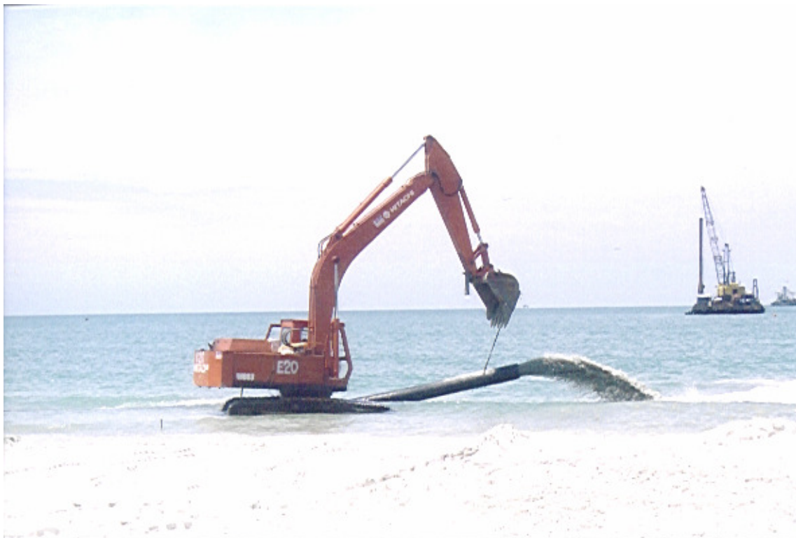
Fig. 1 Indpumpning af sand på stranden i Teluk Chempedak
