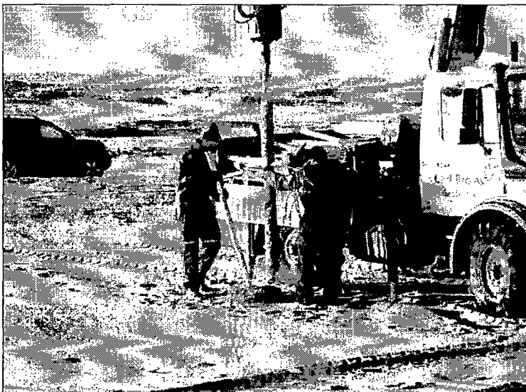
Trykudligningsmodulerne bores ned i stranden og sættes ca. 25 cm under overfladen. (Foto: Poul Jakobsen)
