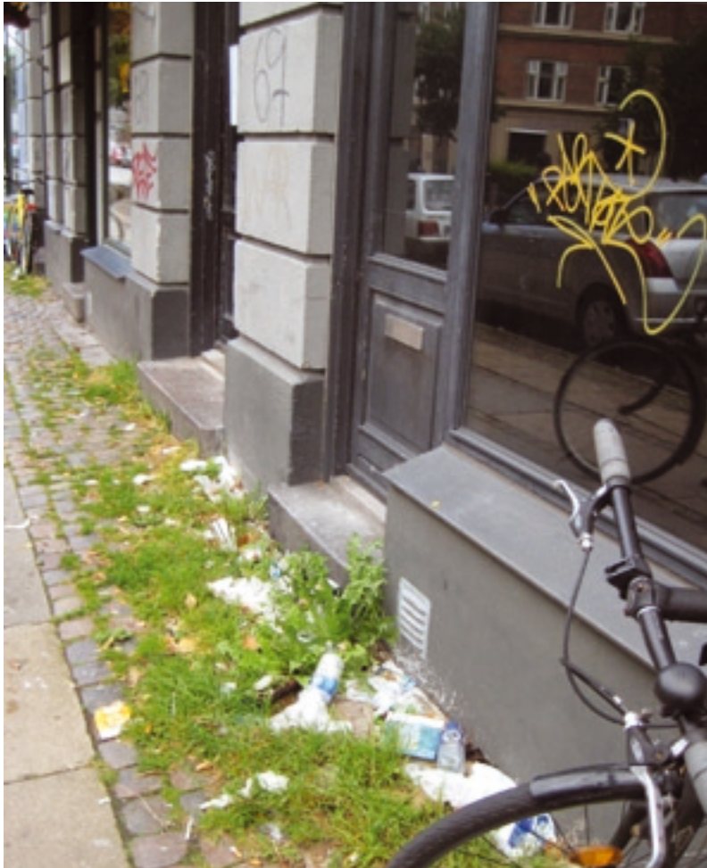
Området mellem fortovet og facaden udgør et ingenmandsland, der tiltrækker affald. Effekten forstærkes af ukrudtet og mængden af graffiti, som giver indtryk af et område uden regler.
