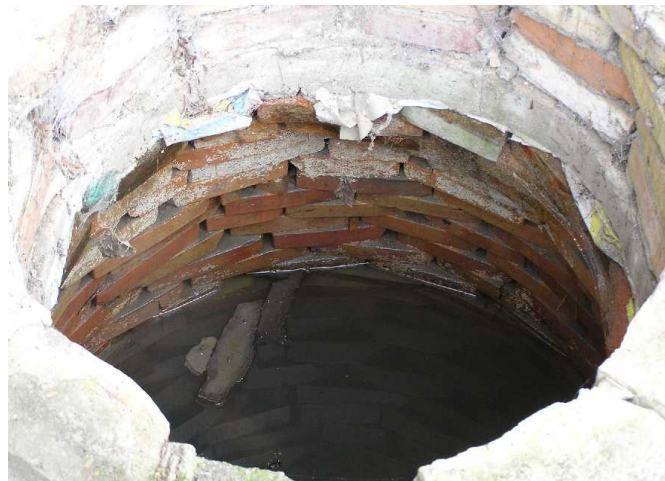
Brønd er konstrueret af løse mursten, og kun i den øvre del er der anvendt mørtel. Det har regnet natten før billede blev taget – læg mærke til at vandet strømmer til ved indsvivning i mur over grundvandspejl.
