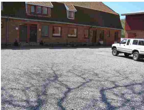
Oversigtsfoto. Brønd ligger på cementdække ved hus. Hb1 er placeret mellem fotograf og brønd.
