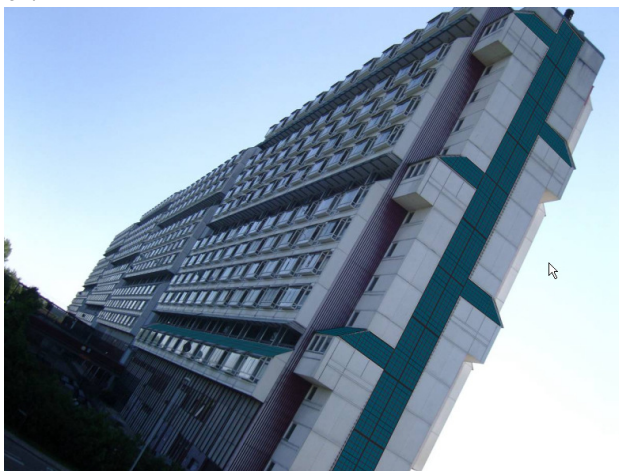
Den sydvendte gavl med krystallinske solceller (blå).
