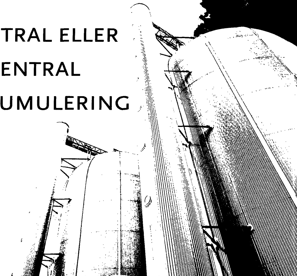
De to akkumulator- tanke ved Avedøreværket Foto: Dong Energy
